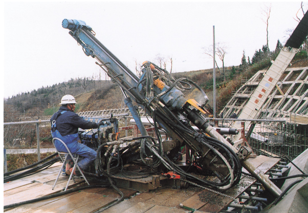
図 5.5.1 ロータリーパーカッションドリルによる削孔状況
