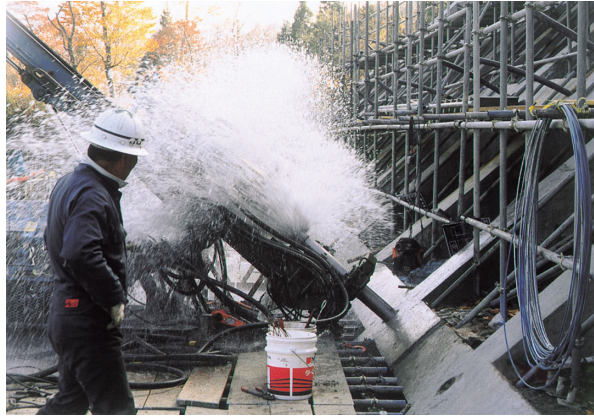
図 5.5.2 孔内洗浄の状況
