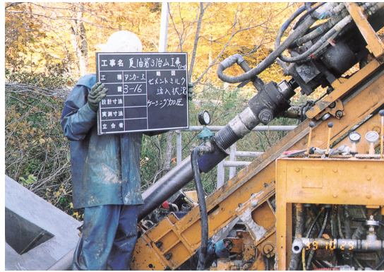
図 5.9.3 加圧ヘッドによるケーシング加圧注入
