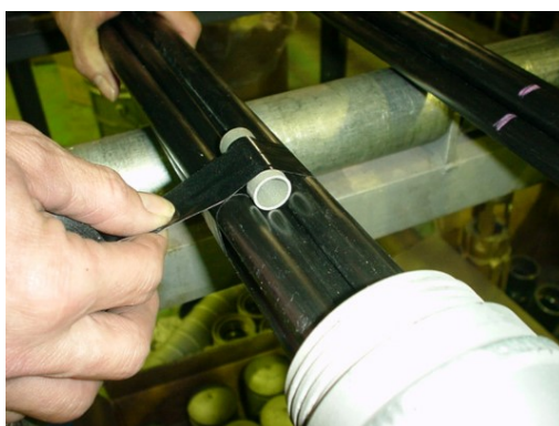
図 5.6.4 円形注入スペーサーの取付状況
