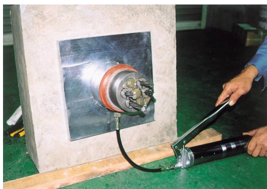
図 5.14.1 ヘッドアダプター内への防錆材の充填
