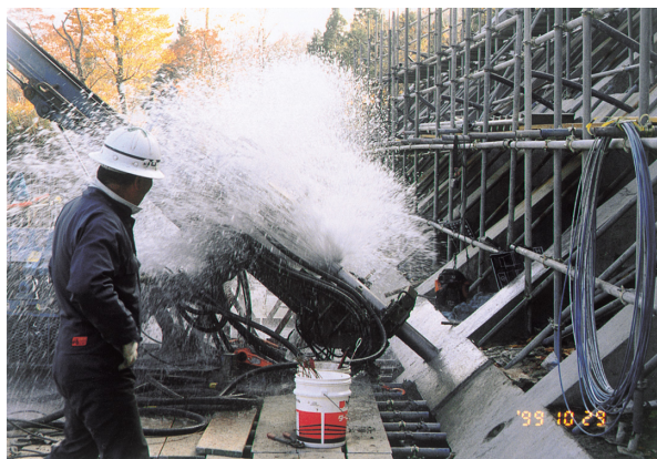
図 5.5.3 孔内洗浄の状況
