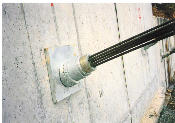
図 4.5.1 角度補正例（アジャストプレート）
