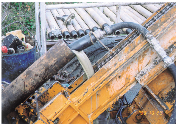
図 5.9.3 置換注入時のグラウトのリターン
