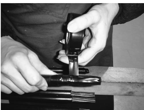
図 5.6.3 アンボンド PC 鋼より線ジャッキ側端部のビニールテープによる処理
