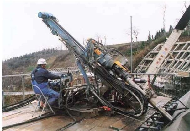
図 5.5.1 ロータリーカッションドリルによる削孔状況
