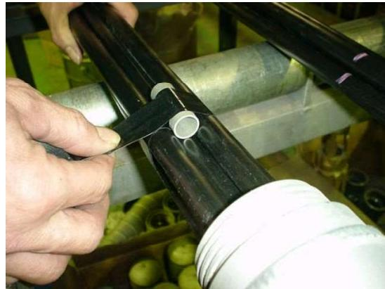
( $\phi 12.7\text{-}4$  では 50 cm 間隔で 2 箇所に 1 個ずつ,  $\phi 12.7\text{-}5$  では同 2 箇所に 2 個ずつの 4 個,  $\phi 12.7\text{-}6$  では 100 cm 間隔で 2 箇所に 1 個ずつテンションが整列するよう取り付ける。)
