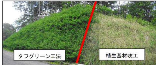
施工1年11ヶ月 (左:タフグリーン工法, 右:植生基材吹付工)
