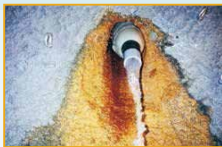
● 孔口止水パッカー施工状況
