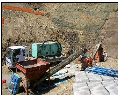
施工プラント
