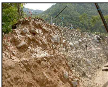
仮設吹付工実施状況
