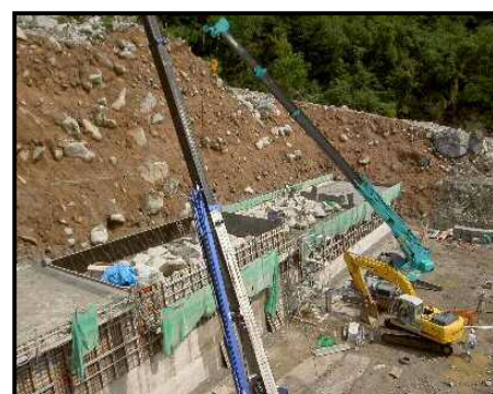
本施工実施状況
