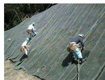
② マット敷設
