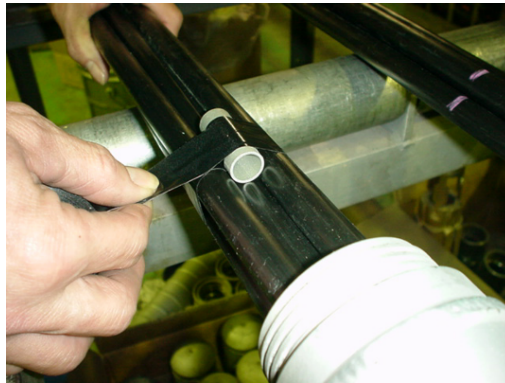
図 5.6.4 円形注入スペーサーの取付状況
