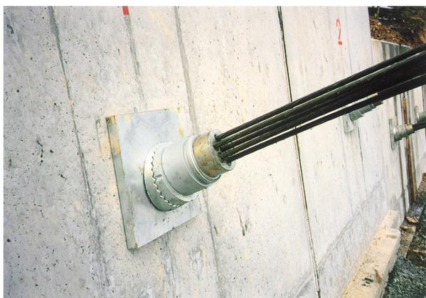
図 4.5.1 角度補正例（アジャストプレート）
