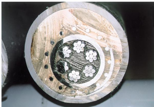
図 1.2.5 アンカー体部の防食構造
