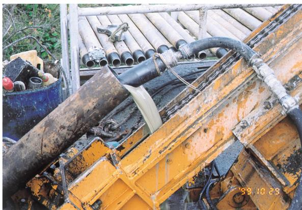
図 5.9.3 置換注入時のグラウトのリターン
