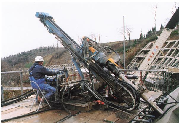
図 5.5.1 ロータリーパーカッションドリルによる削孔状況
