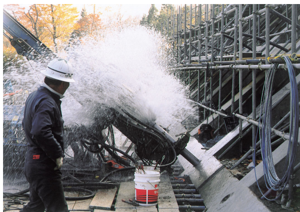
図 5.5.2 孔内洗浄の状況
