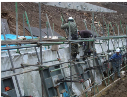
4.足場サポート組立
