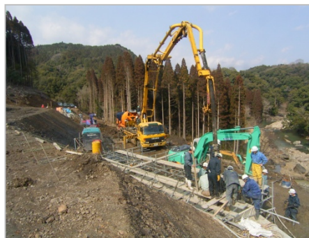
5.注入打設(生コン・ポンプ打設)
