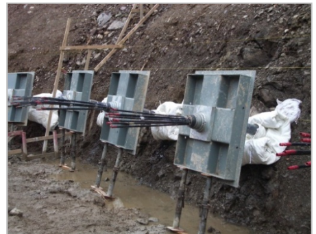
3.布製型枠・小型受圧板設置
