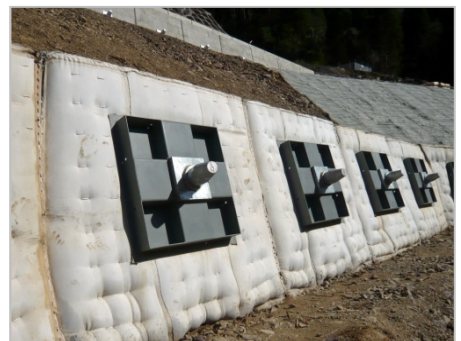
6.養生後、緊張・定着 施工完了
