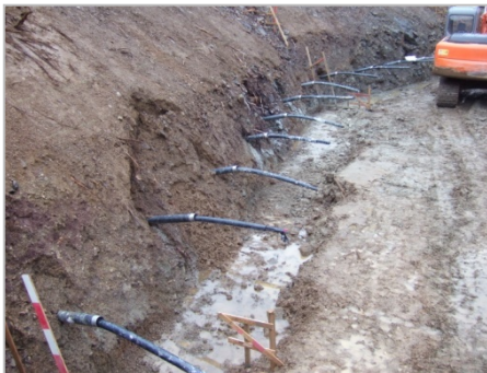
1.アンカー削孔・ガイドパイプ設置
