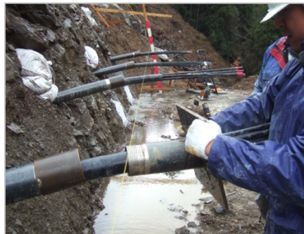
2.プレート付ガイドパイプ設置
