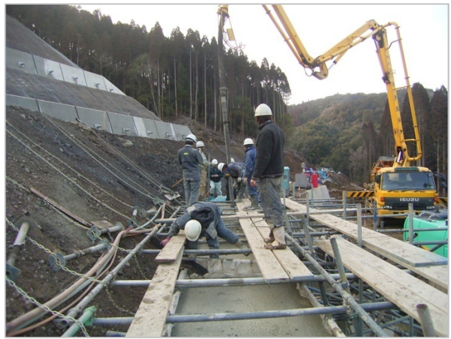
注入打設状況例
