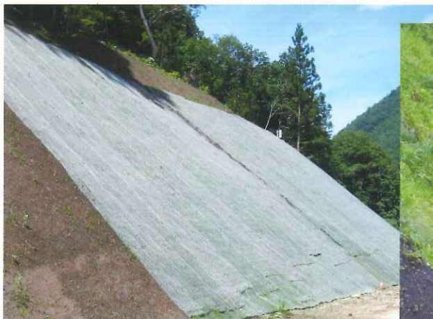
MF-45R-10wn 施工直後
