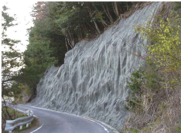
SP-45wn 施工直後
