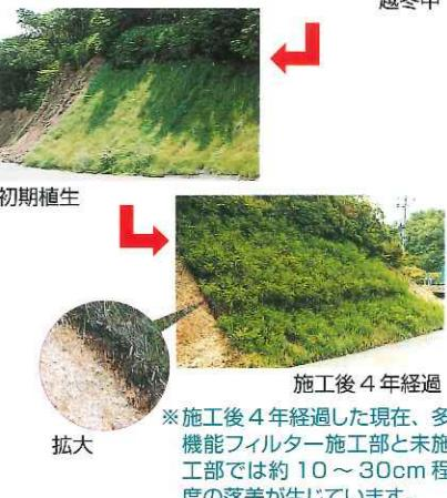
※施工後4年経過した現在、多機能フィルター施工部と未施工部では約10~30cm程度の落差が生じています。
