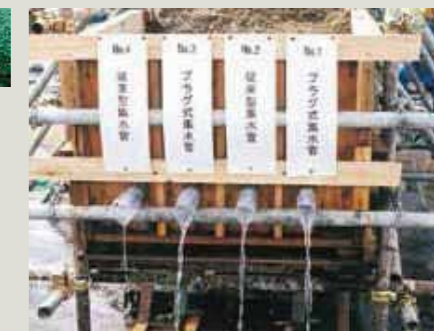
排水状況写真
