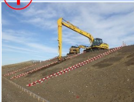
法面(基面)整形
