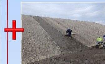
シュートネット養生
